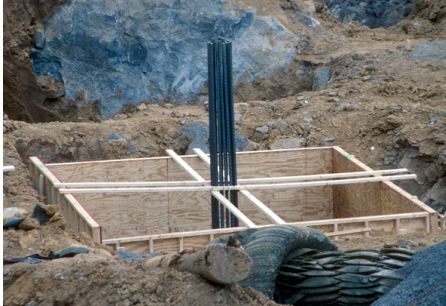
Column bars, forms ready to pour
